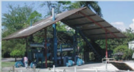
Vista general de la planta
