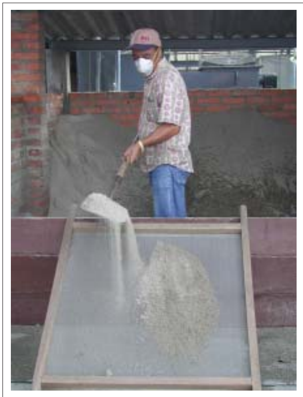
Figura A3. Zaranda para tamizar suelo y arena en el proceso de endurecimiento.
